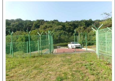
<진입로 포장 현황>
