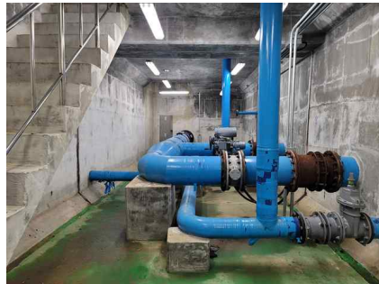
<유입밸브실 지하2층 전경>
