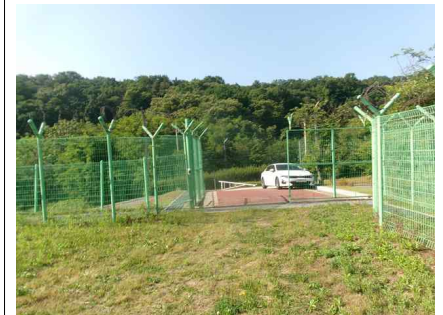
<진입로 포장 전경>
