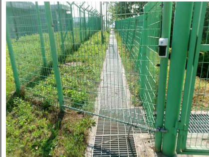
<배수로U 형 전경>
