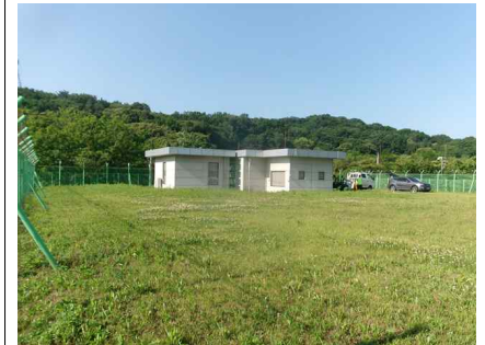
<배수지 상부 전경>
